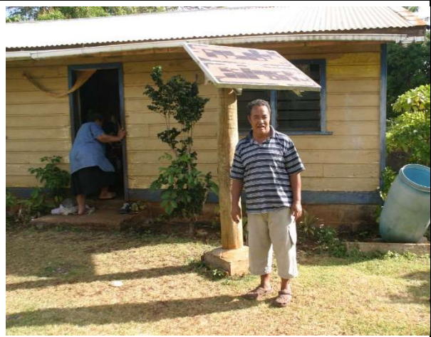
Lape 島の住宅と住民、使用不可の劣化した SHS (Solar Home System) のパネル
