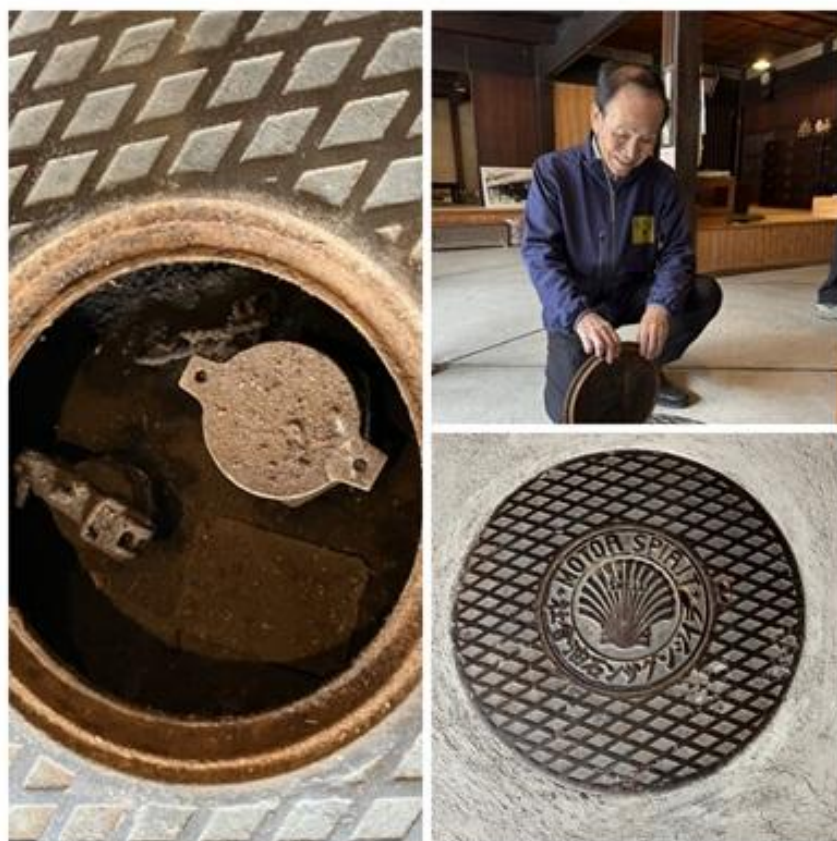
⑧ 玄関土間に残るマンホール(ガソリンの匂いが残ります)
