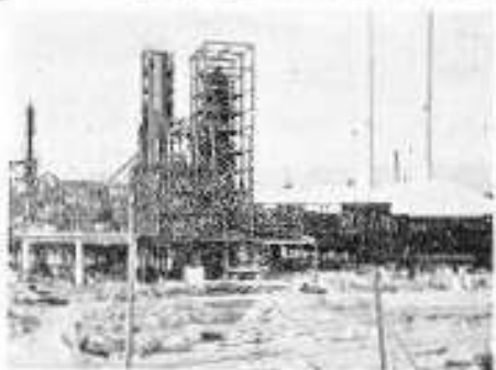
一 新設の塔の建設状況
