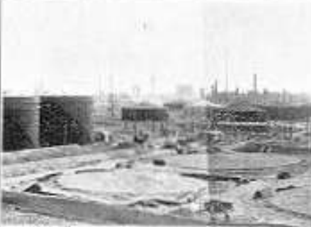
一 大口径タンク基礎工事の進行状況
